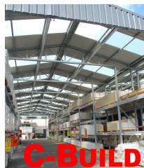
C-BUILD Overdekte opslag
