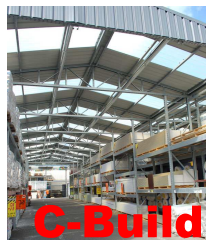
C-Build Overdekte opslag
