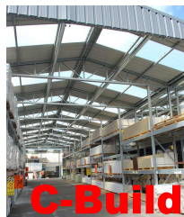
C-Build Overdekte opslag
