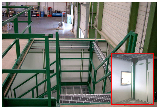
TraviForm® platform met grote overspanning en geïntegreerde trapkooi + Alumel systeemwand eronder.
