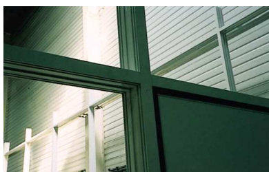
Modulair aluminium geraamte, opgebouwd ter plaatse.
