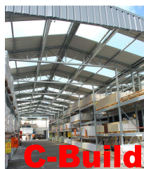
C-Build Overdekte opslag
