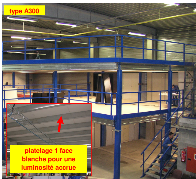
Installation à 3 niveaux, rase dessous et dessus, équipée d'une balustrade amovible et de deux escaliers métalliques.
