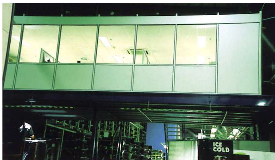
Plate-forme longue portée TraviForm® + cloisons alu au-dessus de l'atelier.
