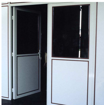
Cloison bureau d'atelier avec double porte battante.
